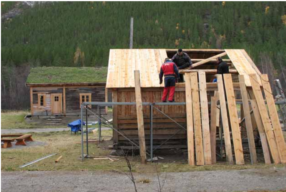
Bilde dra oppsettingen av den store skjelterskjåen på Storjord i Saltdal. Bygget ble satt opp på i underkant av fire dager. Fotograf: Trond Loge.
